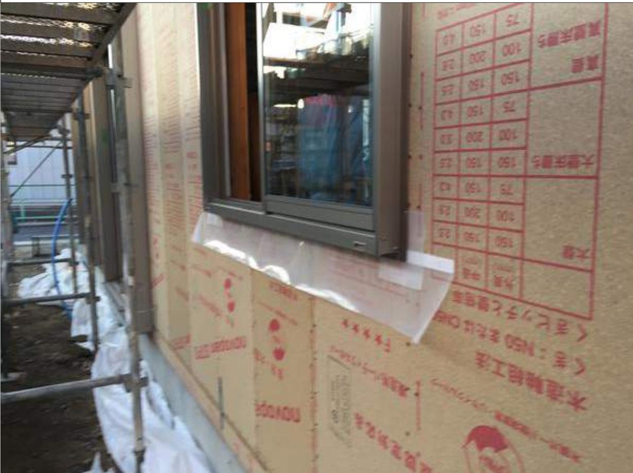
3-2口両面防水テープを用いて、サッシくぎ打ちフィンの根元を十分に覆い、縦・
