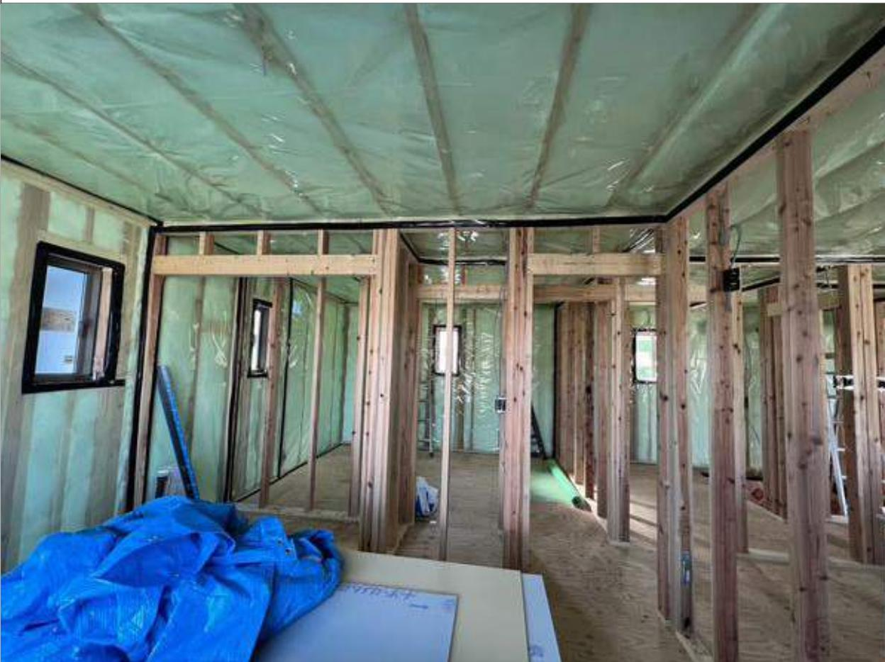
2-2 口屋根断熱の場合、断熱材の外側には通気層を設ける。
